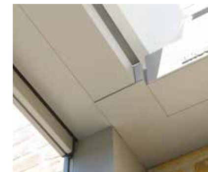
Wasserabfuhr von der Regenrinne direkt in den Stützpfeiler
